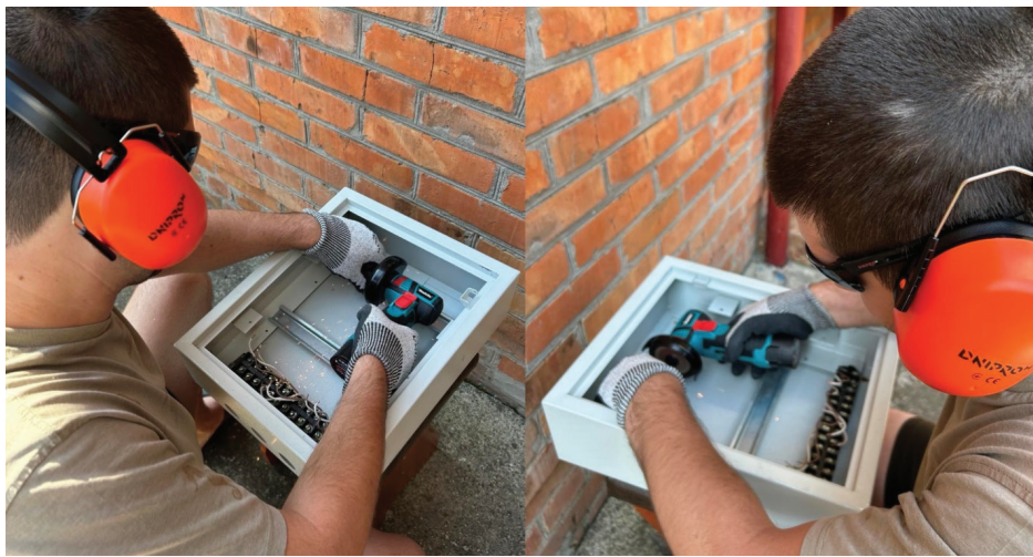
Рис. 1. Використання засобів індивідуального захисту під час користування електроінструментом класу III
