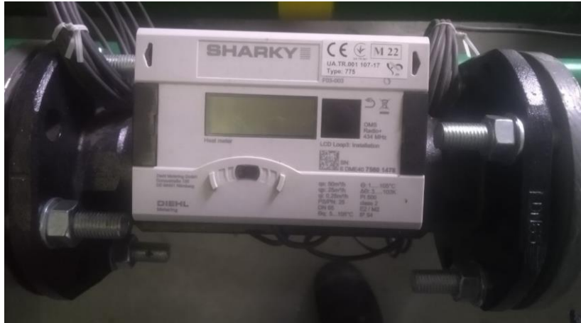
Рис. 7. Ультразвуковий лічильник води для закритих систем SHARKY 775
