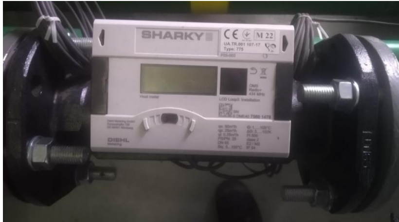
Рис. 7. Ультразвуковий лічильник води для закритих систем SHARKY 775
