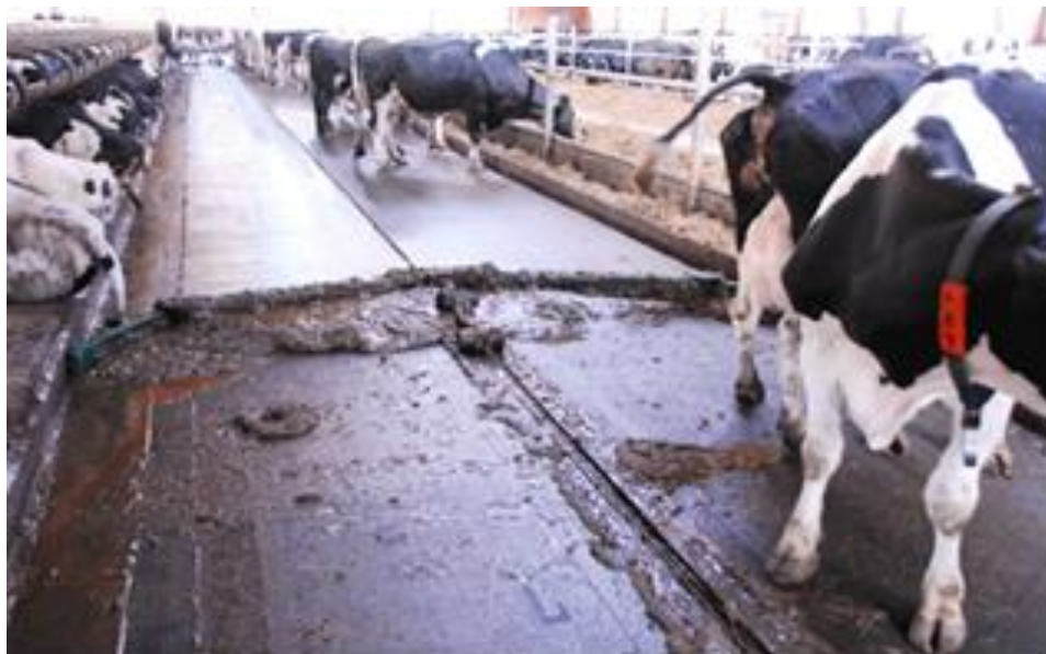
Рис. 1. Гладка бетонна поверхня гнойового каналу
