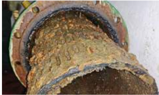
Рисунок 7. Загальний вигляд фільтра попереднього очищення насосного агрегату станції бризкальних басейнів циркуляційної системи ГЦ ВП ЗАЕС при розбиранні
